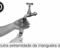
Na outra extremidade da mangueira de alimentação de água, repita os passos 5, 6 e 7 com o segundo engate rápido e, em seguida, encaixe-o no conector instalado na torneira, pressionando até ouvir um "click".
