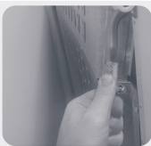
Encaixe a mangueira na conexão de gás
