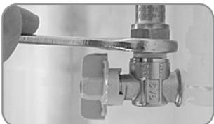
6. Rosqueie a mangueira metálica no registro de gás com o auxílio de duas chaves. Utilize pasta vedante para auxiliar na vedação.
