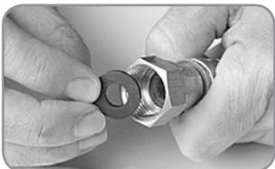
5. Coloque a arruela de vedação dentro da rosca interna da mangueira metálica.
