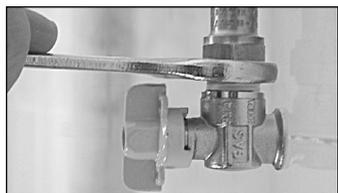
6. Rosqueie a mangueira metálica no registro de gás com o auxílio de duas chaves de boca. Utilize pasta vedante para auxiliar na vedação. O ponto de abastecimento de gás tem que permitir a instalação da mangueira flexível metálica de maneira que ela fique paralela a parede evitando-se assim um estrangulamento.
