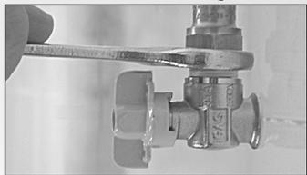
1. Rosqueie a mangueira metálica no registro de gás da parede com o auxílio de duas chaves de boca. O ponto de abastecimento de gás tem que permitir a instalação da mangueira flexível metálica de maneira que ela fique paralela a parede evitando-se assim um estrangulamento.
