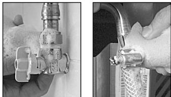
7. Após a instalação, abra o registro de gás e utilizando uma esponja com água e sabão, verifique se há vazamento em todas as conexões, incluindo toda a extensão da mangueira. Se houver formação de bolhas na conexão, refaça-a. Se houver bolhas em qualquer região da mangueira, efetue a substituição da mesma.
